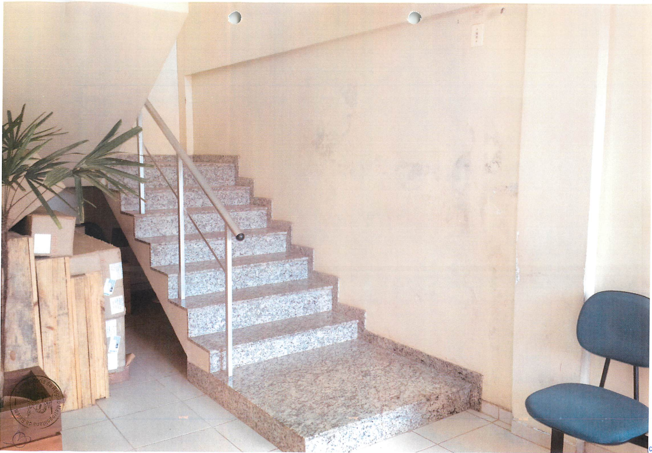
CAIXAS COM PORTA GIRATÓRIA E ACESSO AO 1º ANDAR
