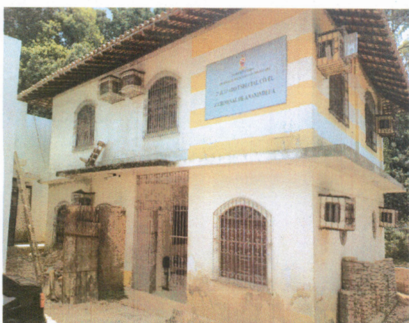
VISTA DO PRÉDIO ANTIGO
