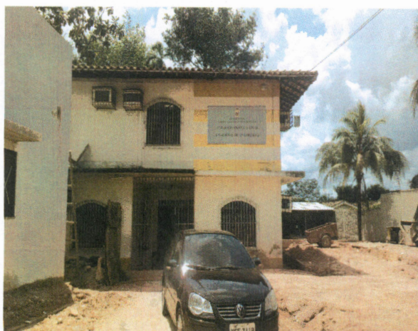
VISTA DO PRÉDIO ANTIGO
