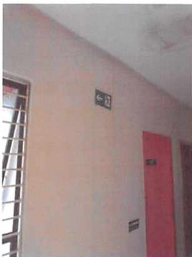
Figura 16 – Pintura do corredor
