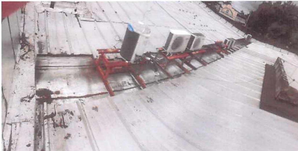
Figura 08 – Impermeabilização de calha.
