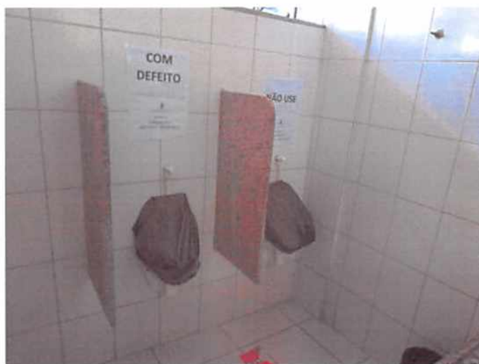
Figura 11 – Reparo da descarga do mictório;
