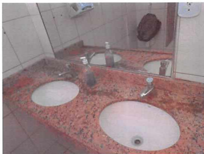
Figura 10 – Substituição de torneiras
