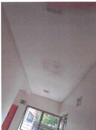
Figura 14 – Pintura do Corredor
