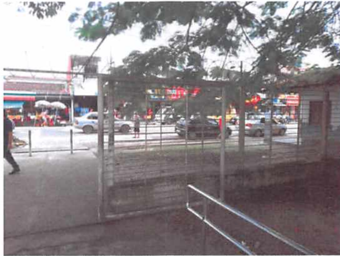
Figura 17 – Pintura do Portão e Gradil de Entrada e substituição de roldana
