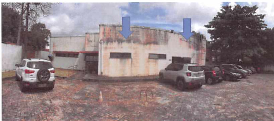
Figura 12 – Pintura e impermeabilização de trincas.
