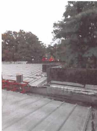
Figura 07 – Impermeabilização de Calha
