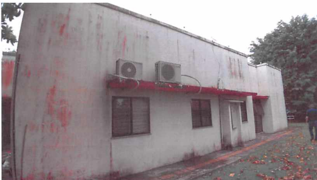
Figura 13 – Pintura do Prédio
