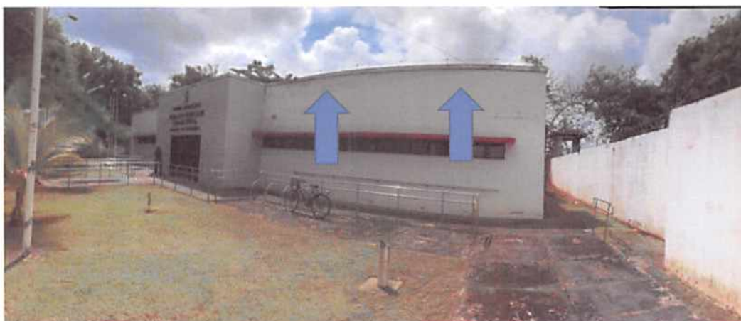
Figura 09 – Instalação de Refletores
