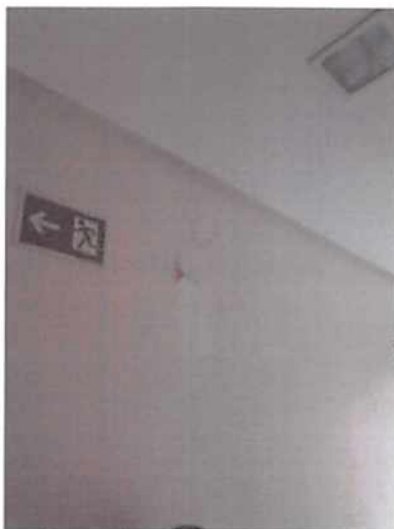
Figura 15 – Pintura do corredor
