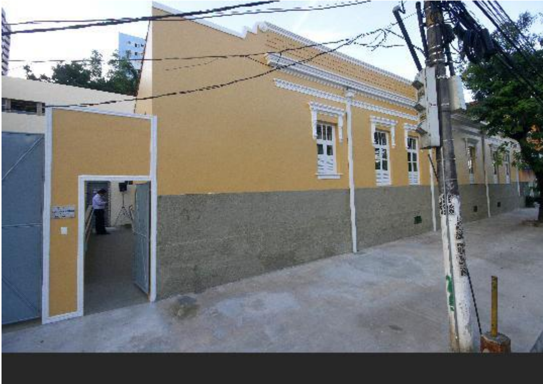
Fachada do prédio onde funciona o novo endereço da Turma Recursal.
