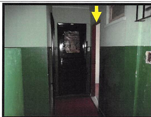
FOTO 10: HALL DE ENTRADA DO APARTAMENTO/SALA.
