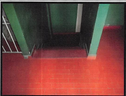
FOTO 11: HALL DE ESCADA SENTIDO DE CIMA PARA BAIXO.
