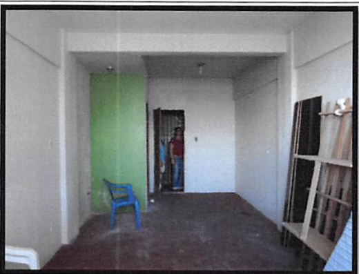
FOTO 13: INTERIOR DO APARTAMENTO/SALA DE DENTRO PARA FORA.
