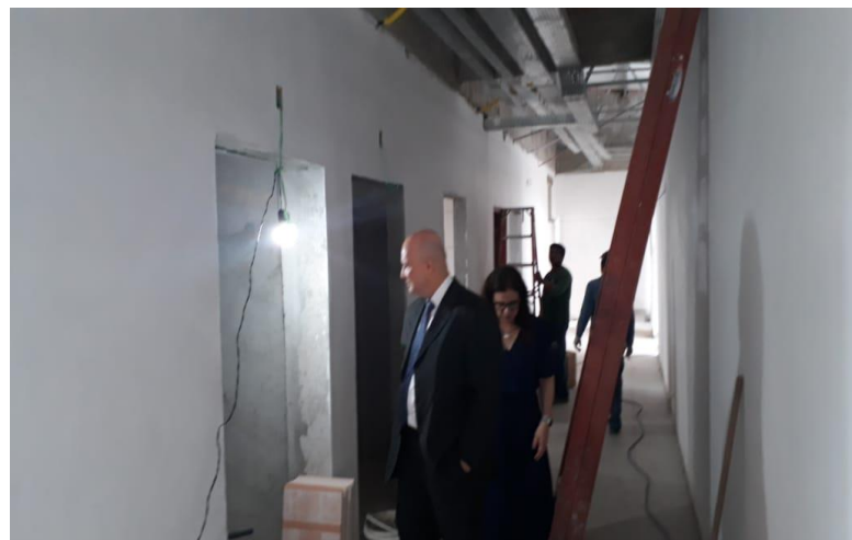
Fotos do Fórum novo em construção durante a inspeção à Unidade
