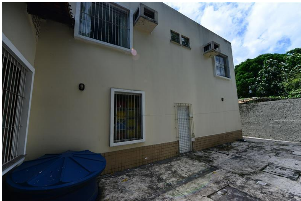
Foto7- Fundo do Prédio
