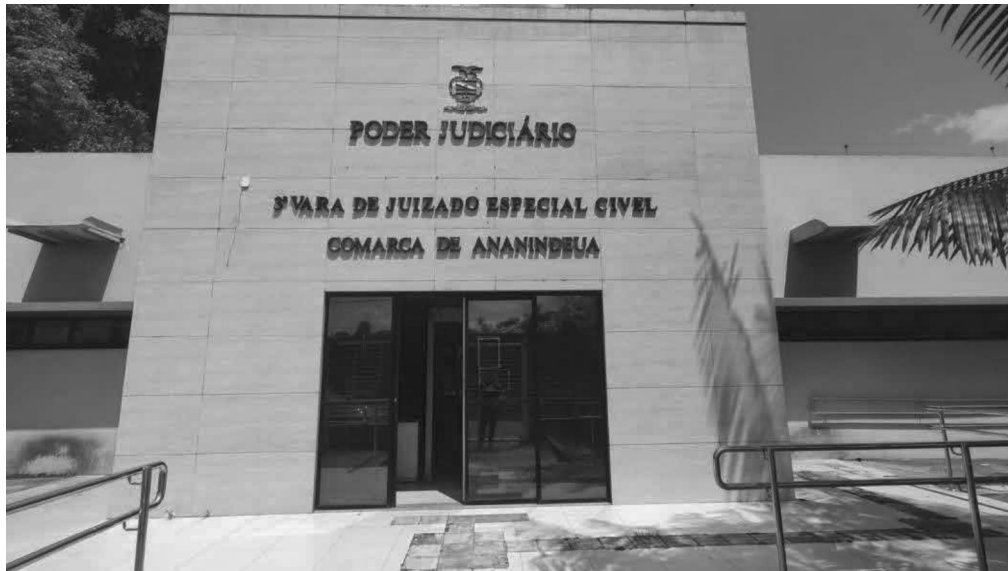
Foto1- Faixada do Prédio do Juizado
