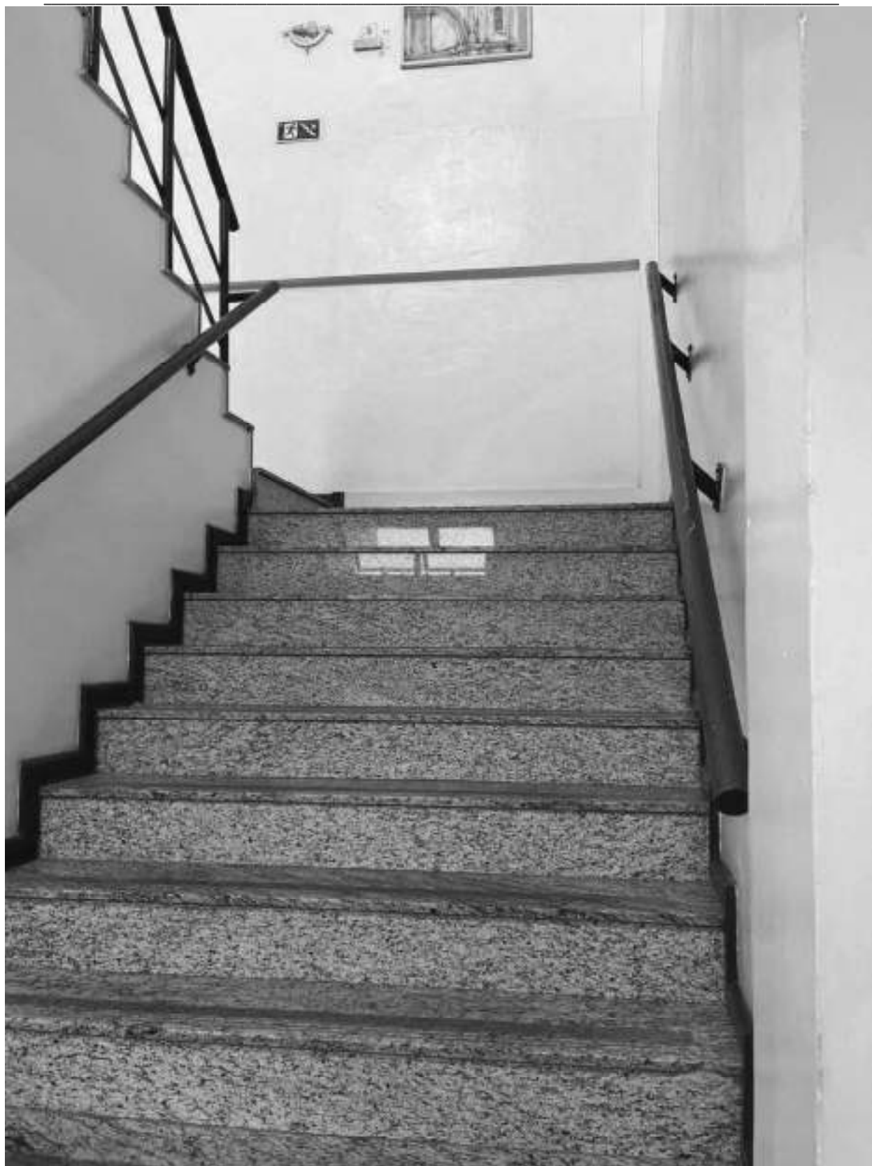
Escada de acesso às Varas de Violência Doméstica e Familiar Contra a Mulher
