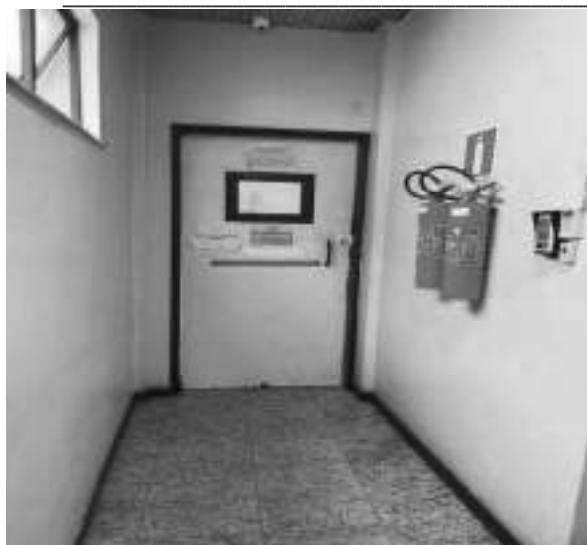
Porta da carceragem que dá acesso ao elevador
