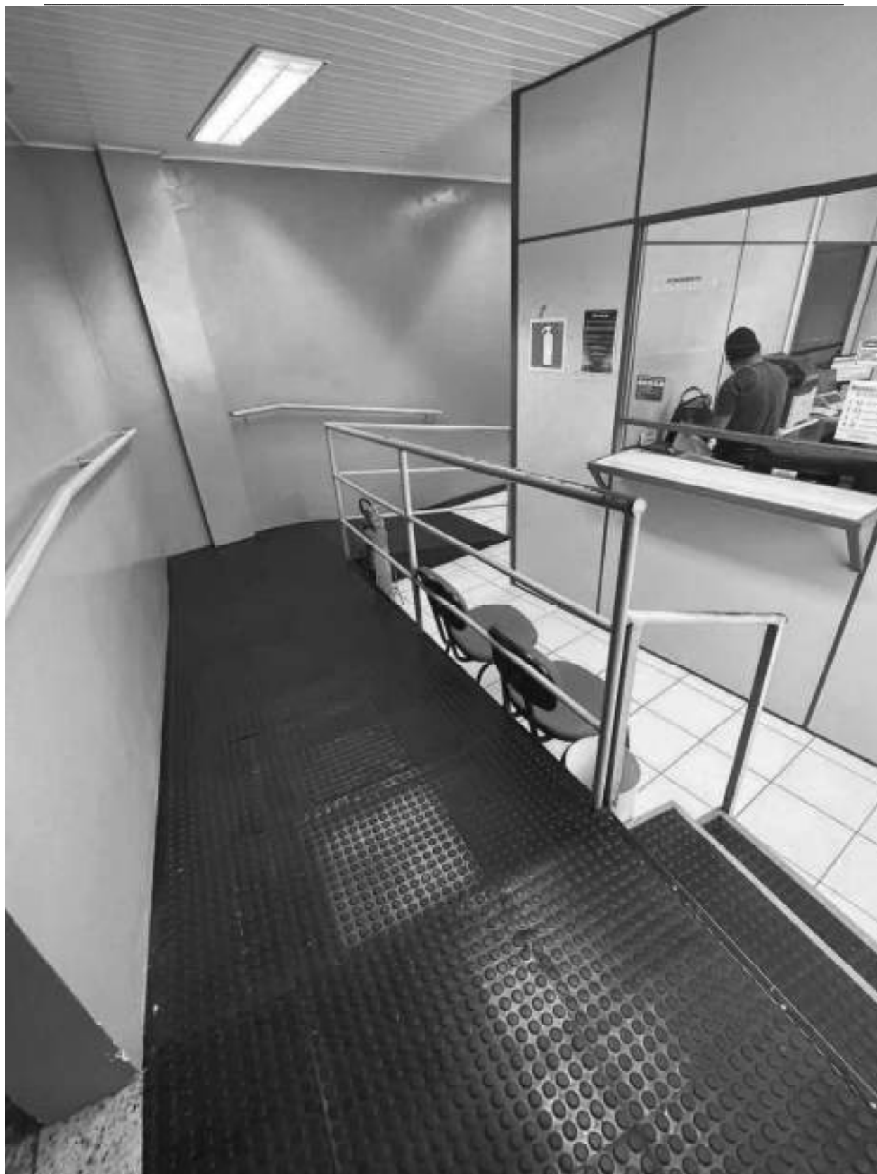
Rampa de entrada da Secretaria e Gabinete
