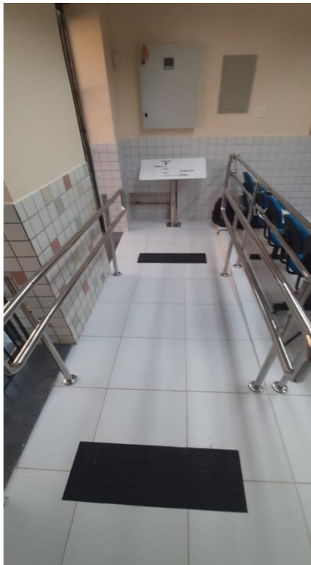
Rampa de Acesso
