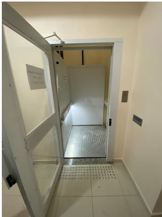
Fórum de Baião Fonte: Secretaria de Engenharia e Arquitetura do TJ/PA
