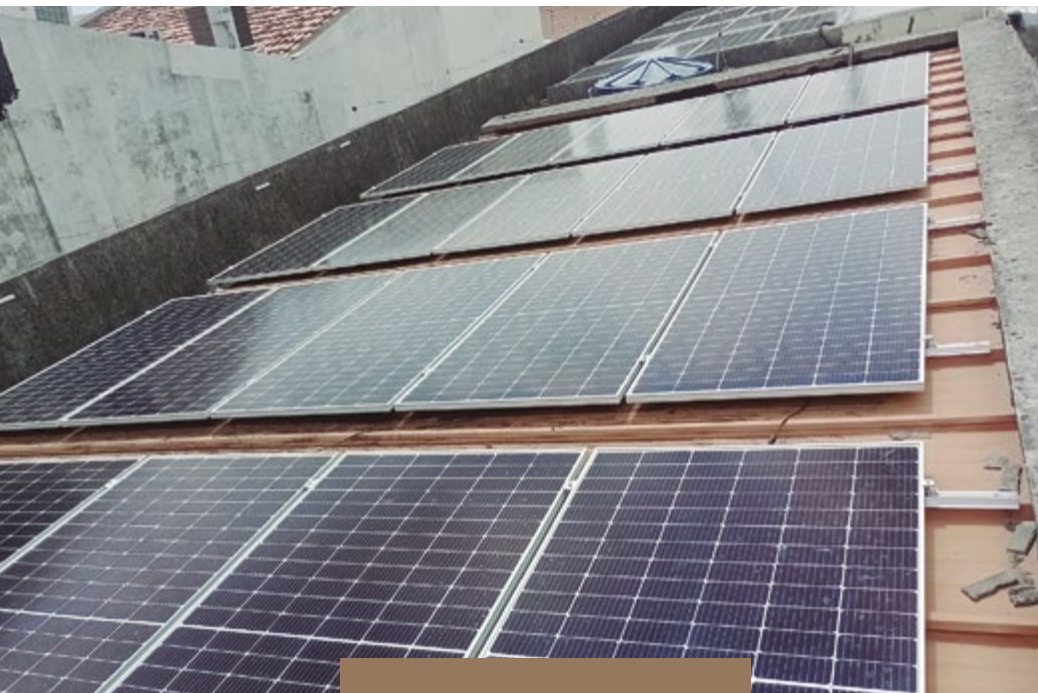
Instalação de sistema fotovoltaico no prédio da Divisão de Manutenção, em Belém
