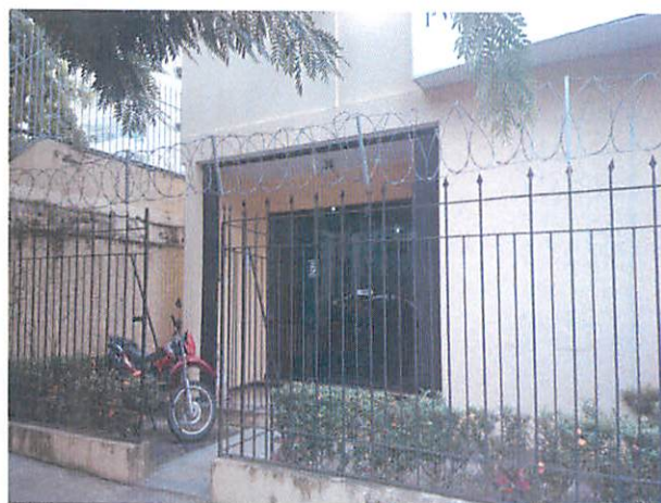
ACESSO AO PRÉDIO
