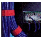
Figura 3 - Cabos unidos com velcro (correto)
