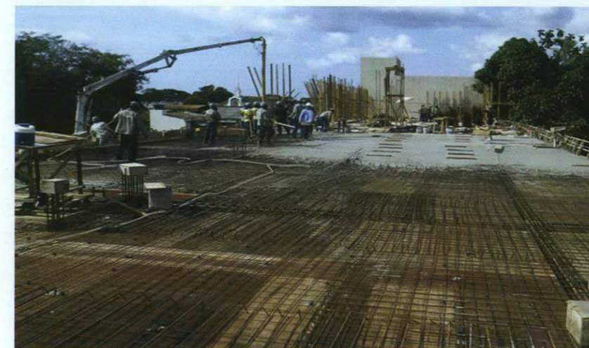
Figura 03. Construção do Bloco II de Ananindeua – Fase de Concretagem da 2ª laje
