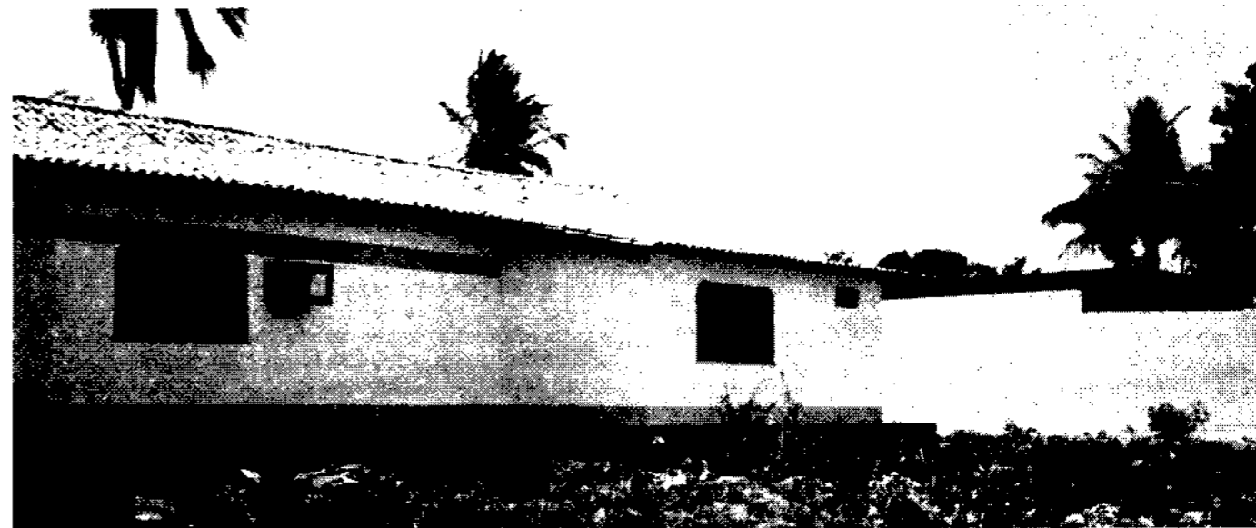
Fórum de A. Corrêa, fachada lateral
