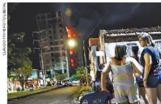
Riscos do prédio já tinham sido denunciados ao MPPA
