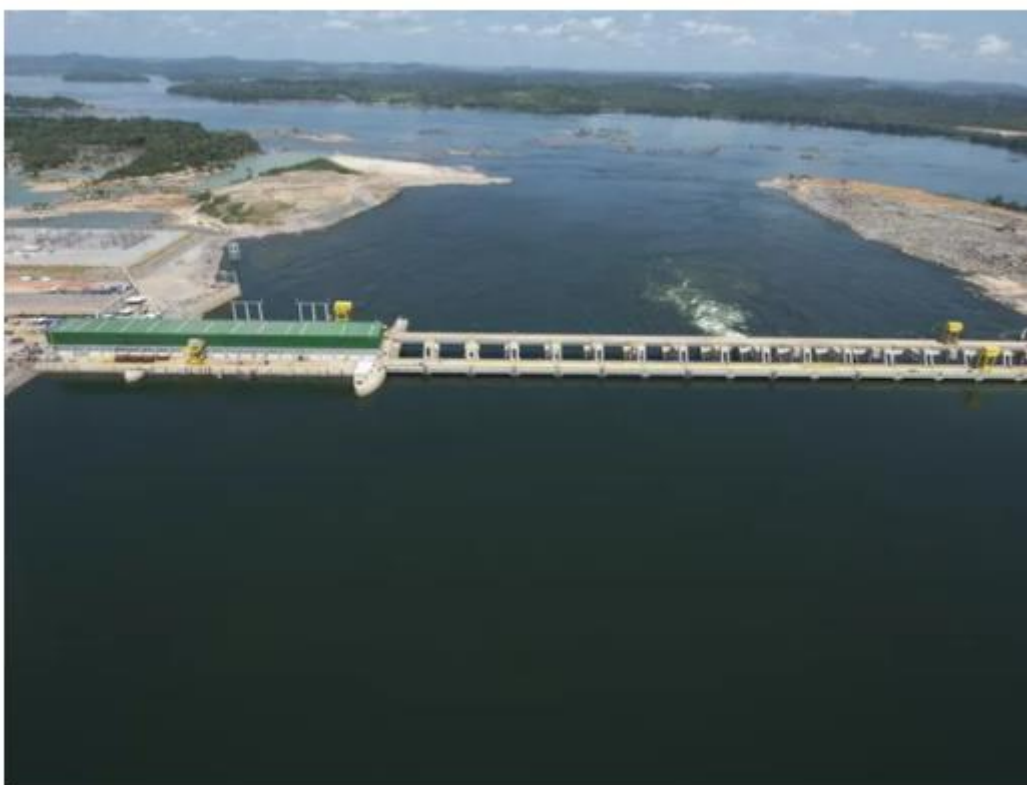
Usina Hidrelétrica Belo Monte fica localizada no rio Xingu, no Pará — Foto: Norte Energia
