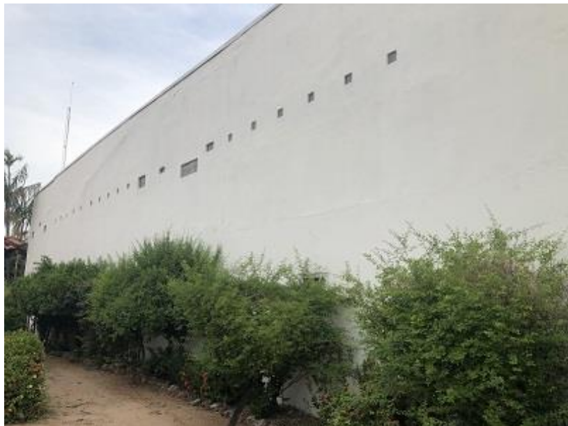
Vista lateral do imóvel .
