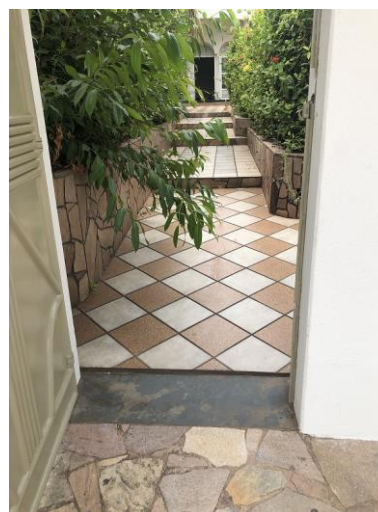
Acesso entrada público, pequenos desníveis.
