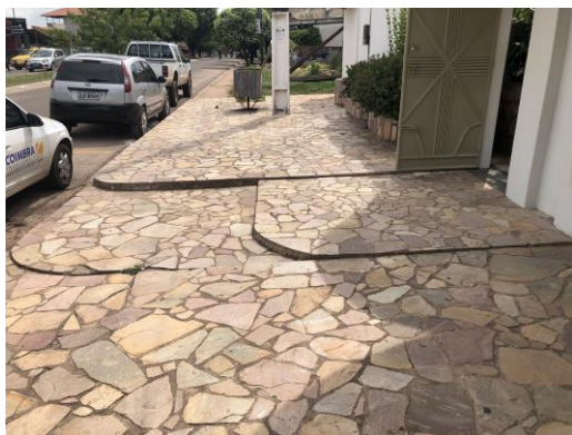
Vista calçada externa.
