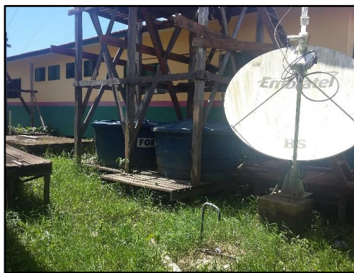
Torre do reservatório elevado, em madeira.
