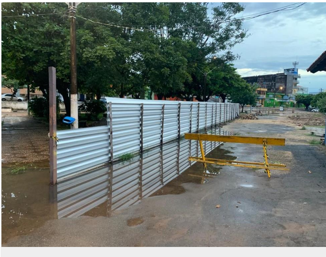
Obras na Praça Rodrigues dos Santos foram paralisadas em janeiro de 2022 — Foto: IHGTap/Divulgação
