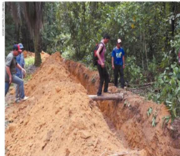
Empresa mandou cavar grandes buracos para impedir deslocamento
